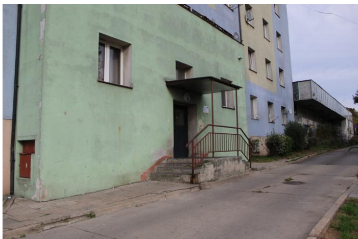
Ryc. 24 Budynek komunalny przy ul. Żeglarzy 7, 2024 r., fot. LIS
