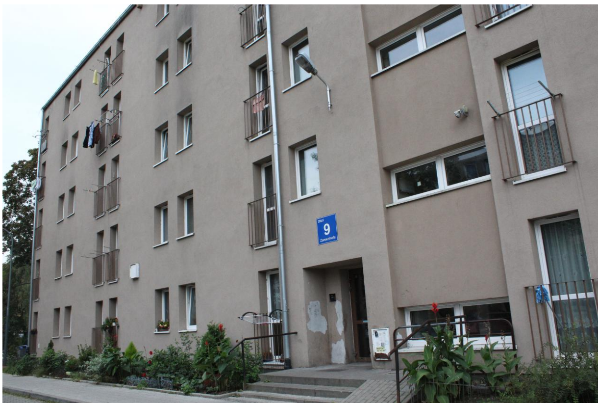
Ryc. 32 Budynek komunalny przy ul. Zamenhofs 9, 2024 r., fot. LIS
