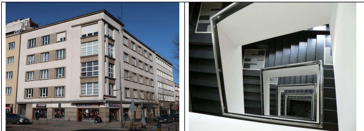
Budynek przy ul. Abraham 28 – elewacje i wnętrze klatki schodowej po pracach restauratorskich zrealizowanych z dofinansowaniem z budżetu miasta Gdyni, pod nadzorem miejskich służb konserwatorskich
