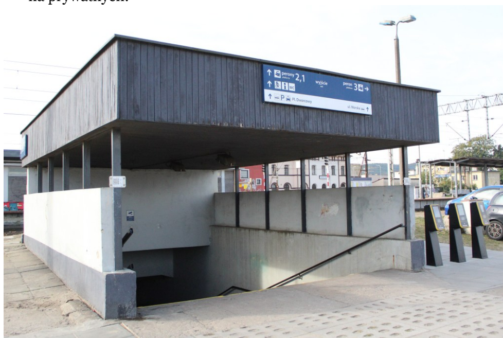
Ryc. 28 Zejście do tunelu prowadzącego na perony i do centrum dzielnicy, 2024 r., fot. LIS
