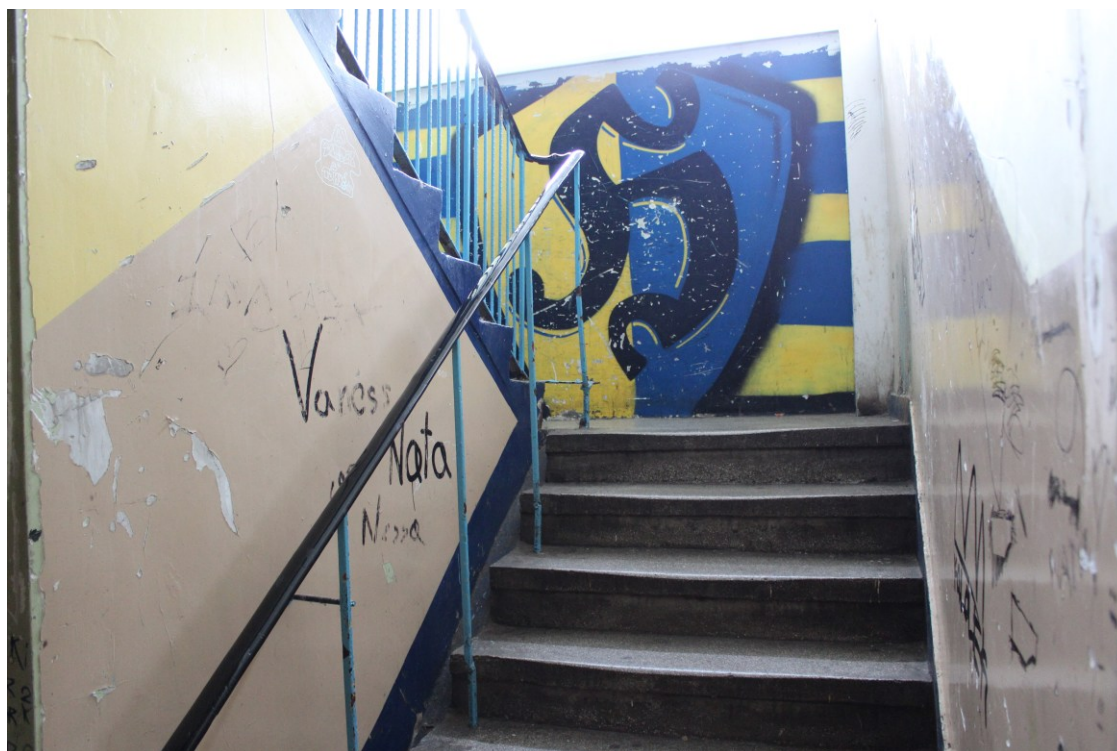
Ryc. 33 Klatka schodowa w budynku komunalnym przy ul. Zamenhofa 9, 2024 r., fot. LIS
