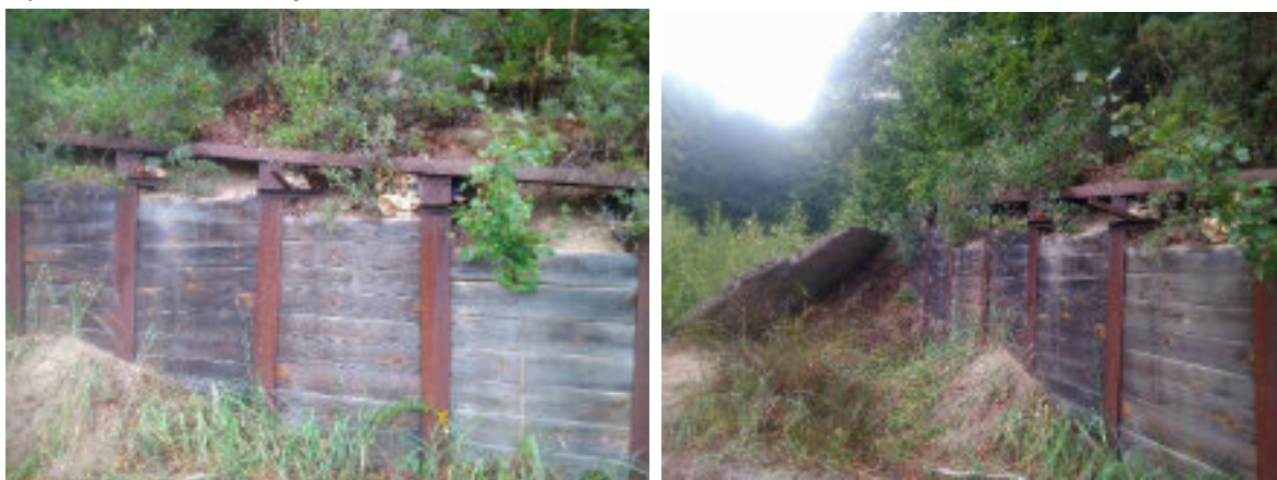
Fot. nr 184, 185. Fragmenty muru oporowego na terenie po byłych basenach, od strony lasu
